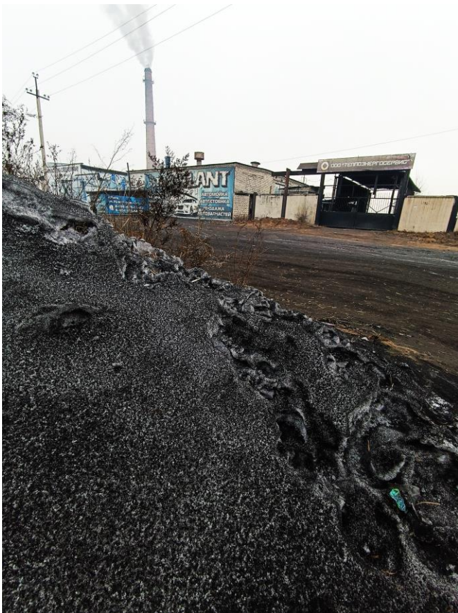
Котельня ООО «Теплоэнергосервис» Фото от 12.02.2024
