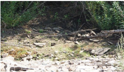
Рис. 3 Насыпь 2 (от участка ул. Веселая, стр. 2 до ул. Солнечная, 32); 08.08.2023: от отметки 708,4 м до 784,3 м – не произведено укрепление мокрого откоса скальным грунтом; 23.10.2023 – дефекты не устранены.
