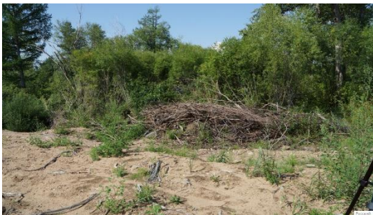
Рис. 5 Насыпь 2: 08.08.2023: от отметки 361,8 м до 491,8 м –вдоль насыпи порубочный мусор; 23.10.2023 – убран частично.
