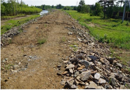
Рис. 2 Насыпь 1 (от участка по ул. Проточная, стр.9 до участка по ул. Казачья, стр. 1); 08.08.2023: отметка 327 м. – трещина, от отметки 327 м до 360,7 м – усадка грунта, от отметки 360,7 м до 371,2 м – провал; 23.10.2023 – дефекты устранены.
