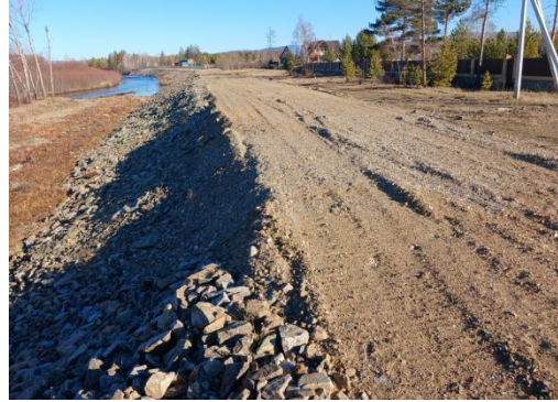
Рис. 2 Насыпь 1 (от участка по ул. Проточная, стр.9 до участка по ул. Казачья, стр. 1); 08.08.2023: отметка 327 м. – трещина, от отметки 327 м до 360,7 м – усадка грунта, от отметки 360,7 м до 371,2 м – провал; 23.10.2023 – дефекты устранены.
