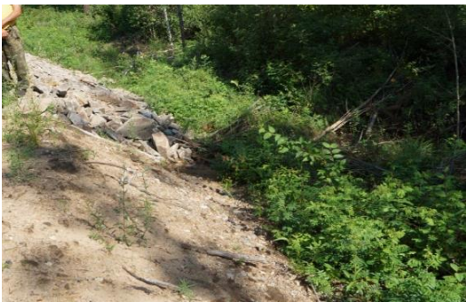
Рис. 3 Насыпь 2 (от участка ул. Веселая, стр. 2 до ул. Солнечная, 32); 08.08.2023: от отметки 708,4 м до 784,3 м – не произведено укрепление мокрого откоса скальным грунтом; 23.10.2023 – дефекты не устранены.
