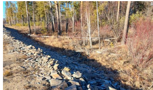
Рис. 3 Насыпь 2 (от участка ул. Веселая, стр. 2 до ул. Солнечная, 32); 08.08.2023: от отметки 708,4 м до 784,3 м – не произведено укрепление мокрого откоса скальным грунтом; 23.10.2023 – дефекты не устранены.
