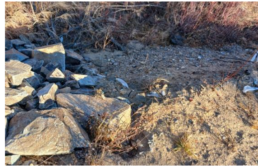
Рис. 3 Насыпь 2 (от участка ул. Веселая, стр. 2 до ул. Солнечная, 32); 08.08.2023: от отметки 708,4 м до 784,3 м – не произведено укрепление мокрого откоса скальным грунтом; 23.10.2023 – дефекты не устранены.
